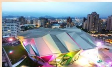
北部流行音樂中心興建工程(北基地)
