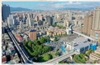
捷運環狀線CF660A區段標工程
