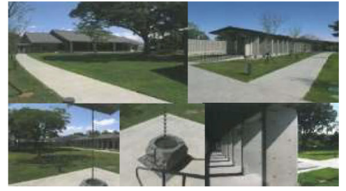
大溪齋明寺·清水混凝土造型
